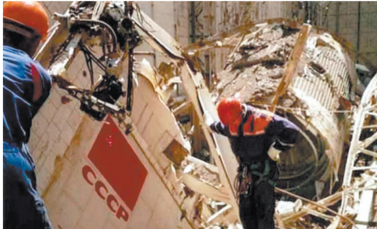
Одна из позорнейших страниц истории современной России: разрушение многоразового космического корабля «Буран» вместе с ракетоносителем «Энергия» в результате падения крыши монтажно-испытательного комплекса на Байконуре. 12 мая 2002 г.
