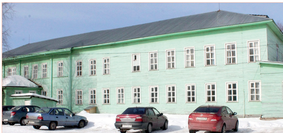
Верховажская ЦРБ. Почти обреченный на закрытие корпус. Фото: «Верховажский вестник».
