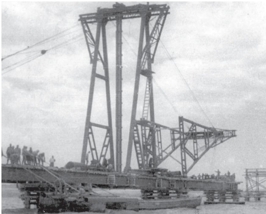
Планировалось, что изначально разделенные ж/д и автомобильный подходы сойдутся уже над Керченским проливом в двухэтажном пролёте, чтобы не строить две судходные арки. По проекту автомобильная дорога должна была проходить на втором ярусе, а железная — на первом.
