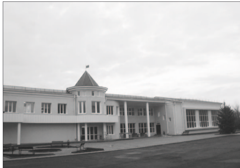
Дом культуры после реконструкции
